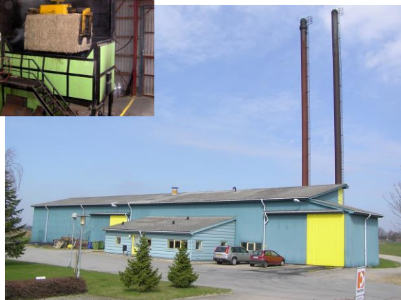
St. Merløse Varmeværk
